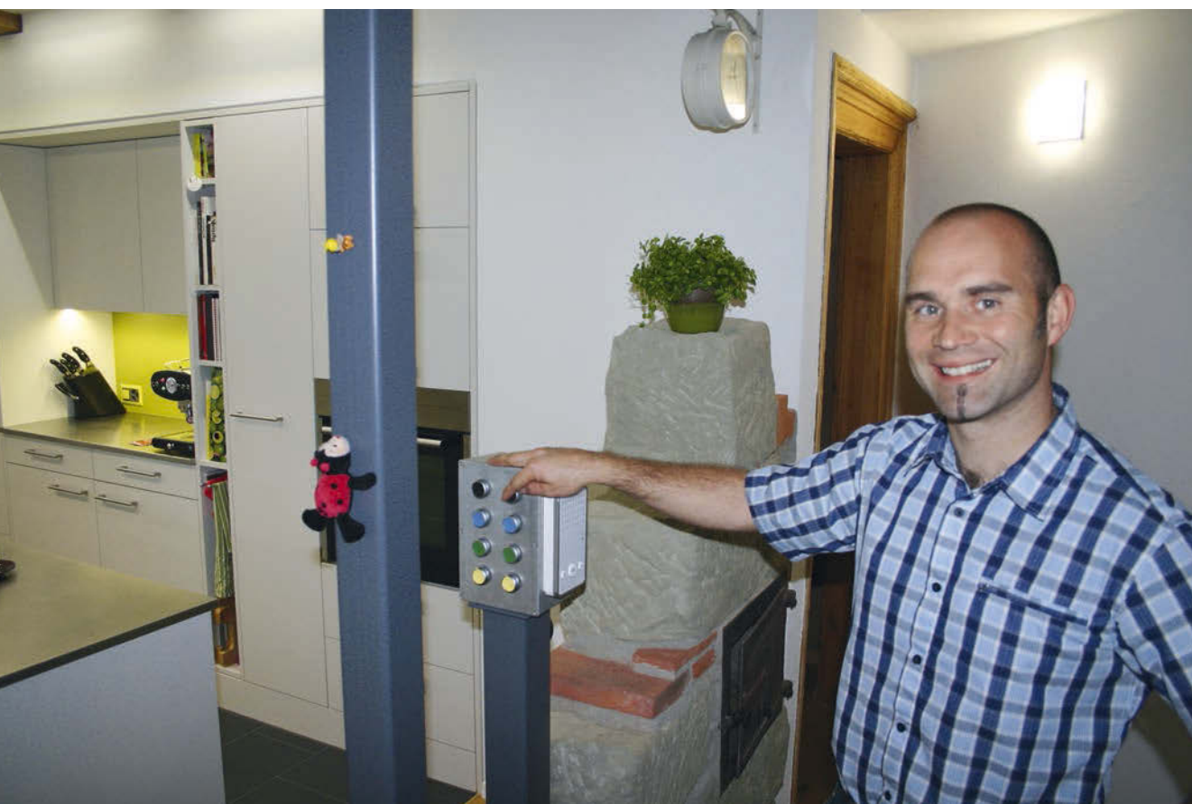
Andreas Bieri an seiner individuellen Bedienstation. Da sich zur Bedienung von Digitalstrom-Anwendungen beliebige Taster eignen, können für die Lichtsteuerung auch Schaltelemente aus der Industrie verwendet werden.
